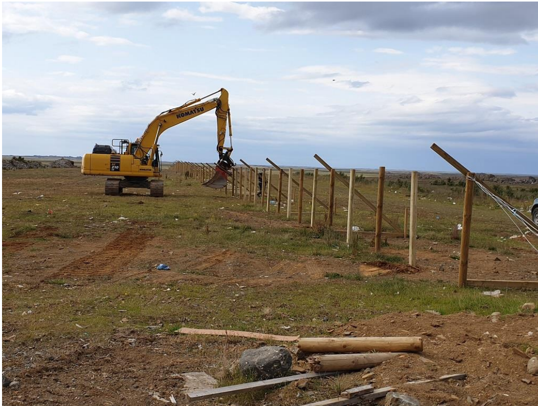
Mynd 10. Unnið við uppsetningu fokgirðingar í Fíflholtum sumarið 2019. (Ljósm. Stefán Gíslason)
